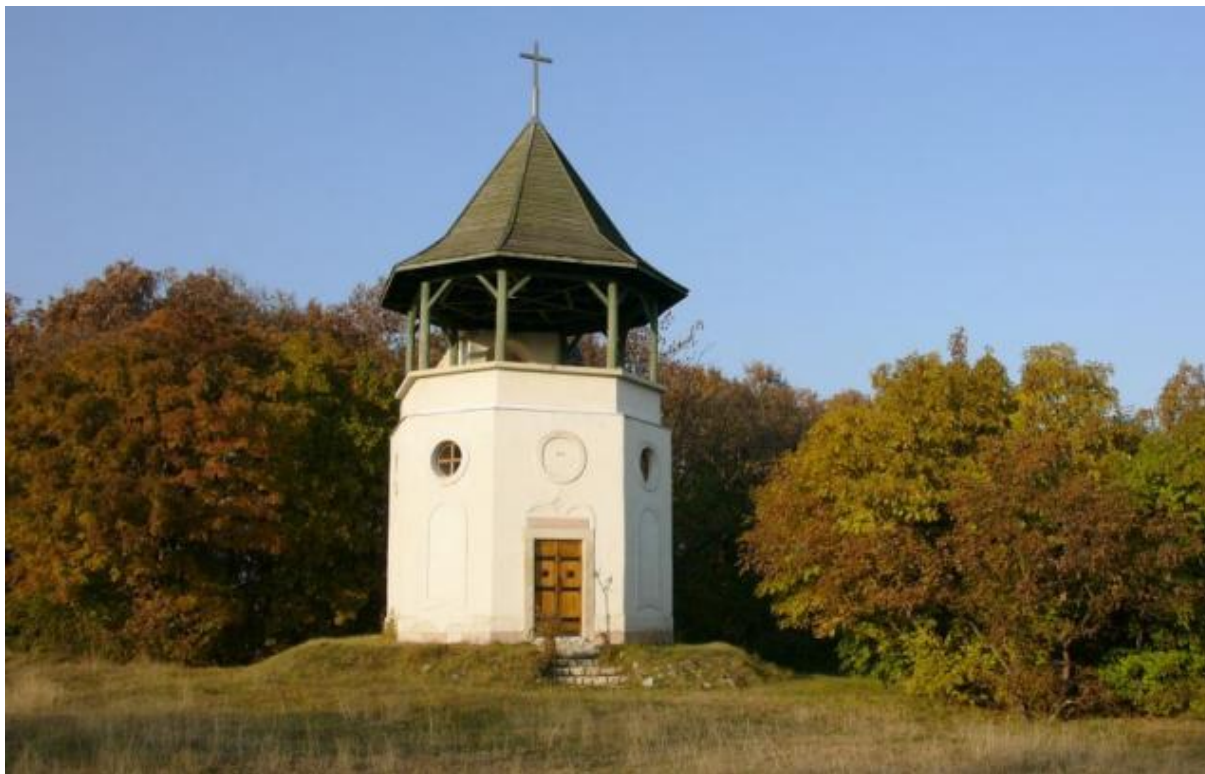
77. ábra: A Vadászkápolna jelenlegi állapota
