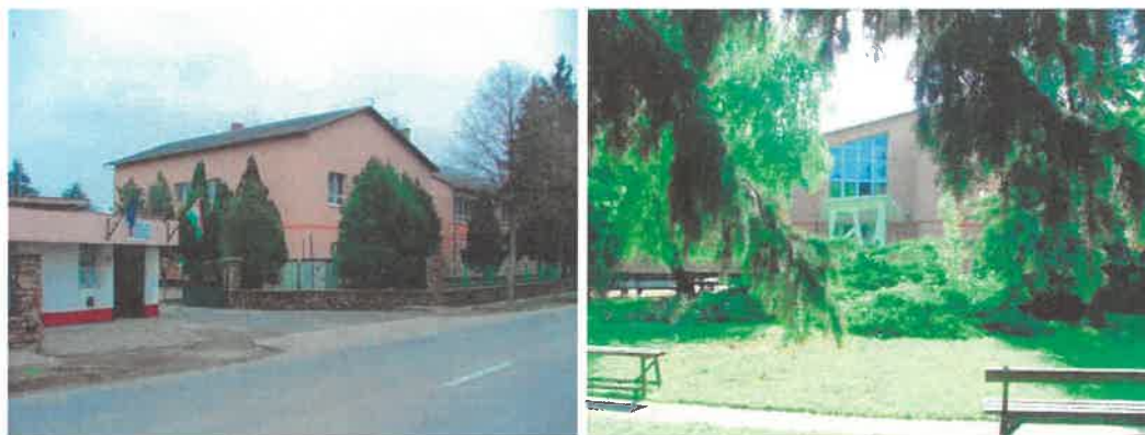
17. ábra – Kisalföldi ASzC Eötvös József Technikum, Szakképző Iskola és Kollégium épülete
